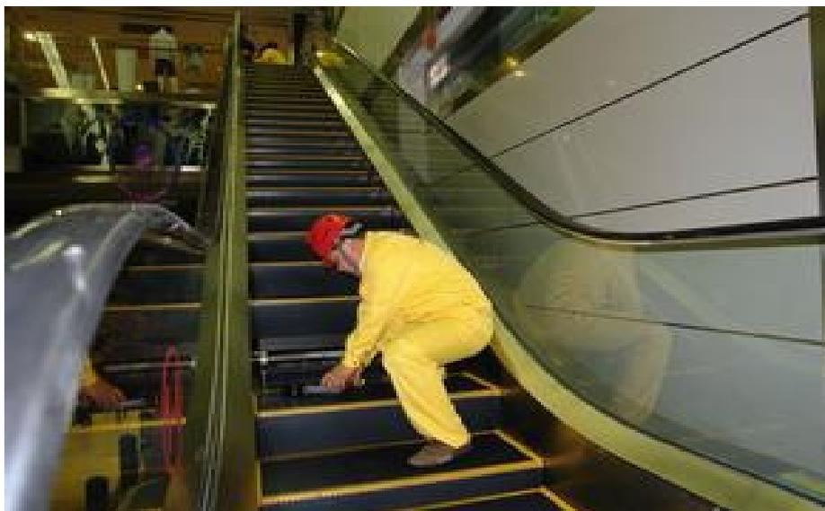
图 23: 检验人员在电梯进行检验
