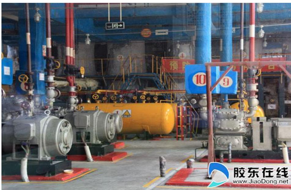
图 22: 氨制冷用压力容器压力管道
