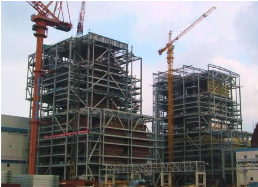
图 5：建设中的电站锅炉
